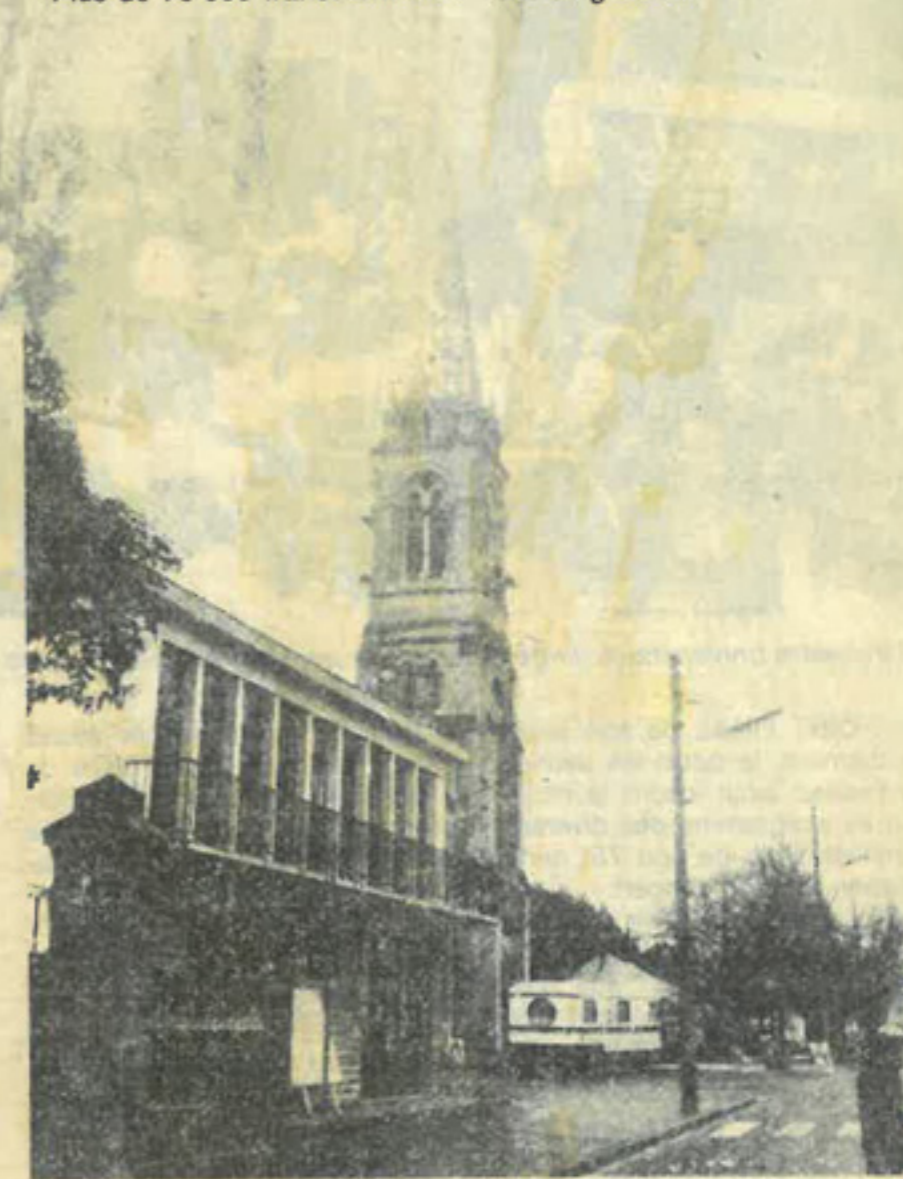
Des travaux à une hauteur respectable.
